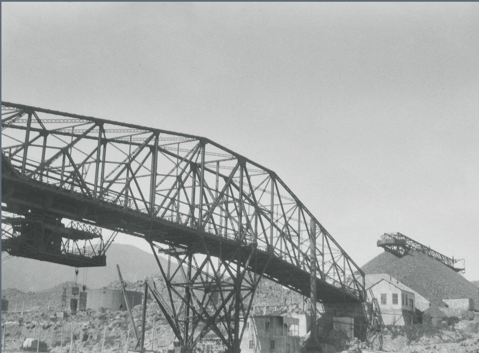
Caleta de Cruz Grande. Sección del cantiléver, detrás se aprecian los estanques de combustible.
