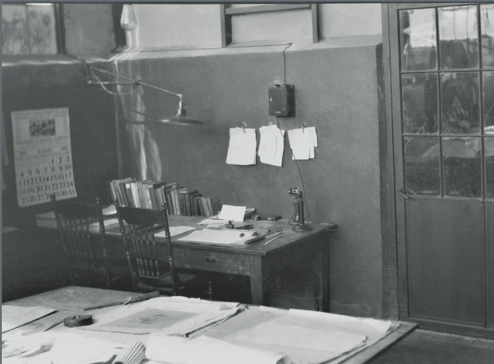
Interior de una oficina en El Tofo. Probablemente la que utilizaba el ingeniero Johann B. Altermatt.
