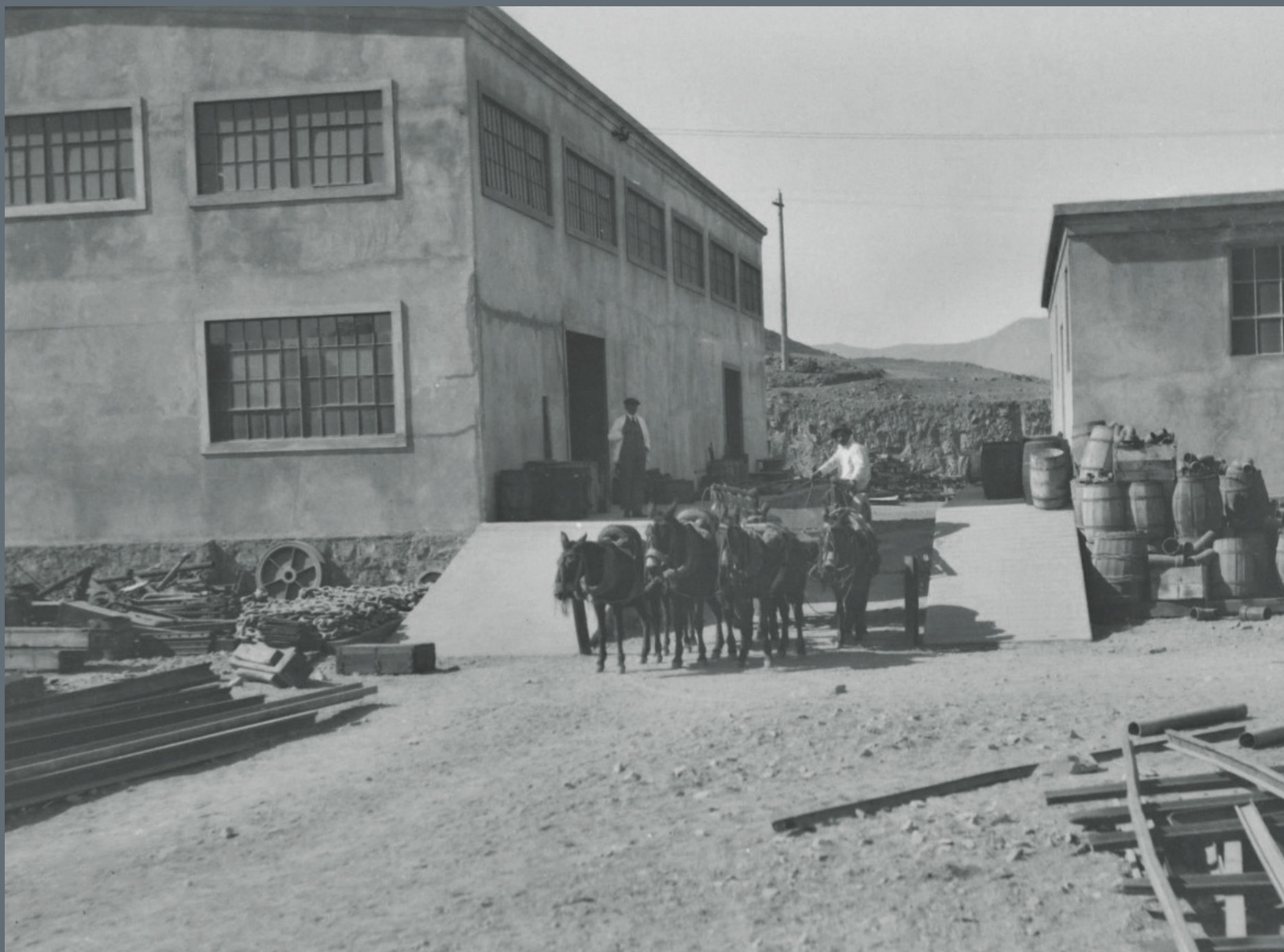
Vista del sector Maestranza en El Tofo, área donde también se encontraba la bodega de materiales. Estas piezas o repuestos de menor tamaño y peso eran distribuidas en carretas tiradas por mulas. En el caso de piezas de mayor peso existía un “ramal” del ferrocarril que llegaba directamente a su interior.
